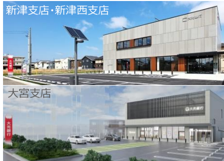
①「新津支店・新津西支店」、「大宮支店」の新築移転（ZEB Readyの認証を取得）
