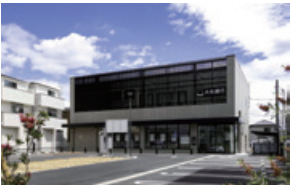
2025年12月に新築した大宮支店 (ZEB Readyの認証を取得)
